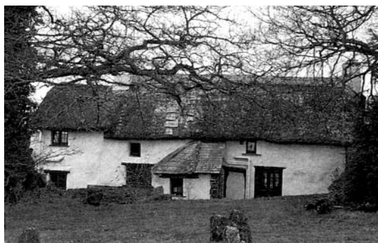
Дом XVI века возле Тавистока в Девоне. Известковая штукатурка поверх самана. Пятьсот лет беспощадных Североатлантических штормов и проливных дождей ничуть не повредили его.
