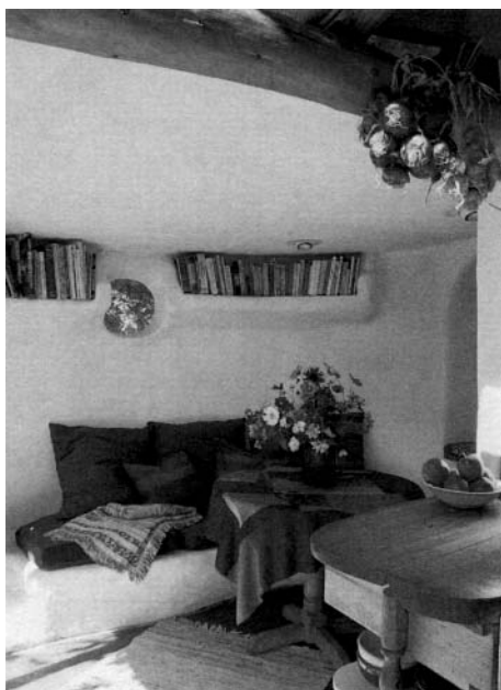
Уголок для сидения в Доме «Сердце». Саманная лавочка с подогревом внизу, вверху книжные полки из самана, выступающие в виде ступенек.
