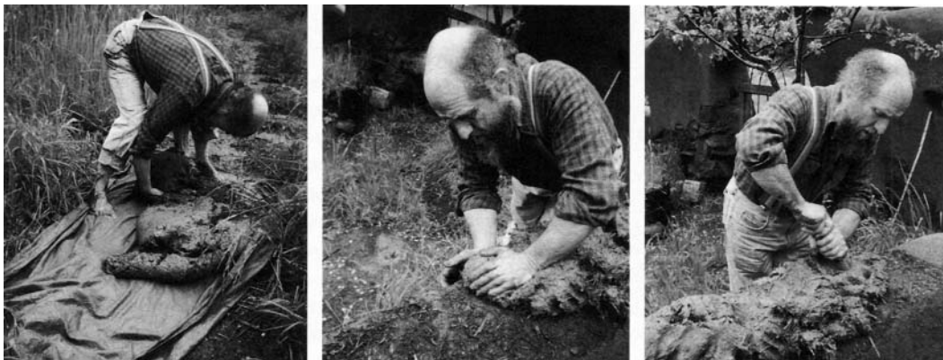
Янто поднимающий большие комья, укладывающий их и пришивающий их с помощью саманного пальца.
