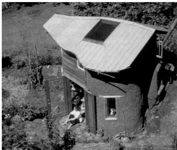
Вид на Дом «Сердце» с восточной стороны. Южная сторона в основном из стекла, для пассивного солнечного отопления
