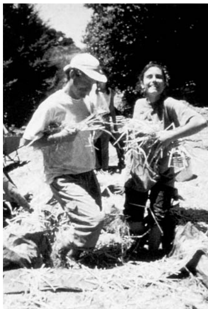
Танцовщики в грязи, добавляющие солому в саманную смесь. Яма была сделана драпировкой брезентом четырёх кип соломы.
