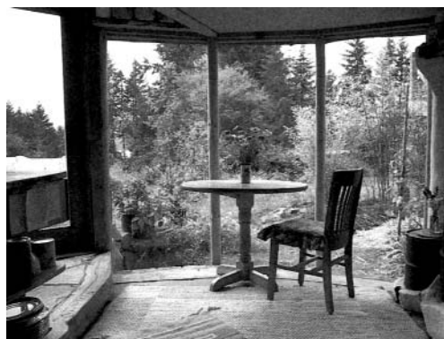
Трехстворчатое окно, многогранное, выступает всего лишь на 25см. при длине в 2,6 м., и в то же время комната кажется значительно больше.
