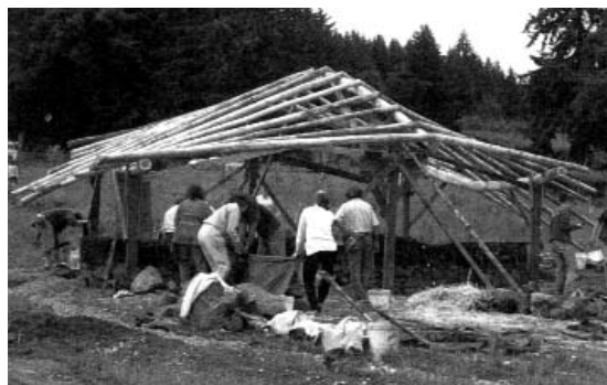
Изогнутый коньковый прогон поддерживает стропила из круглого леса, создавая сложную скульптурную крышу саманного дома в Орегоне.
