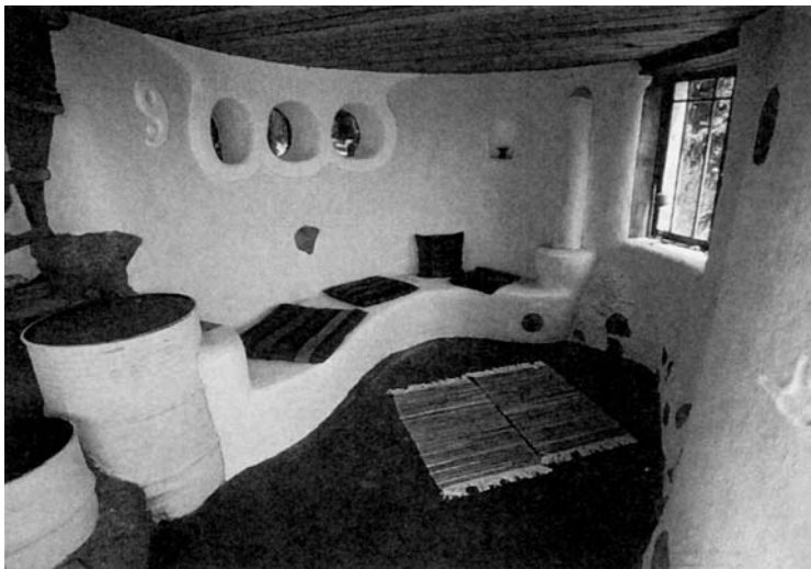
Печь "Ракета" обратной тяги обогревает 3х метровую скамью. Земляной пол с покрытием из льняного масла с воском. Дизайн и конструкция: Cob Cottage Company, 1994 - 95.
