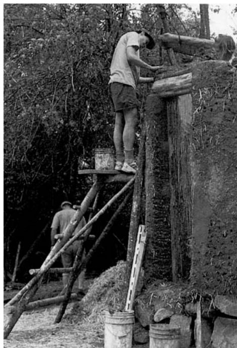
Самодельные козлы из брёвен высотой 1,5 метра
